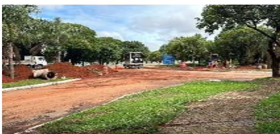
Drenagem Pluvial da Avenida nas Mangueiras
