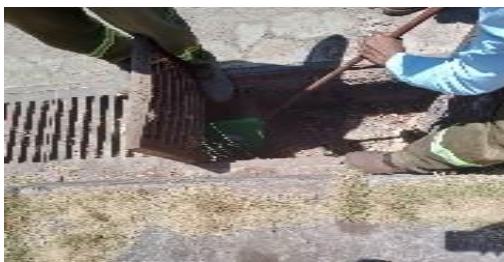
Limpeza e desobstrução de Bocas de Lobo
