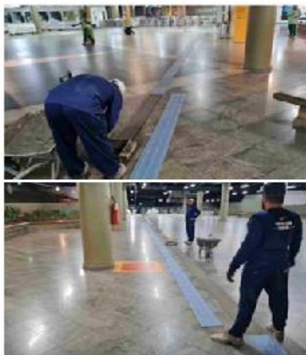
Instalação de pisos táteis
