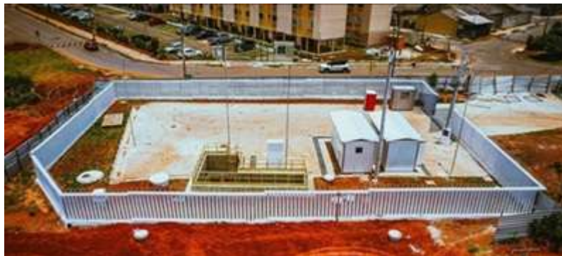
Elevatória de Esgoto Bruto no Riacho Fundo II
