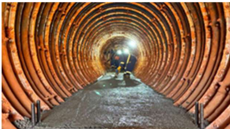
Instalação da Subadutora Gama 111
