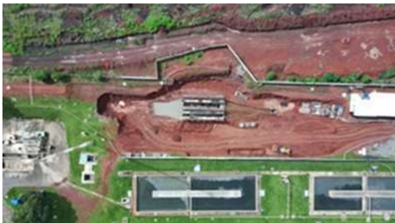
Obra do tratamento preliminar da ETE Paranoá
