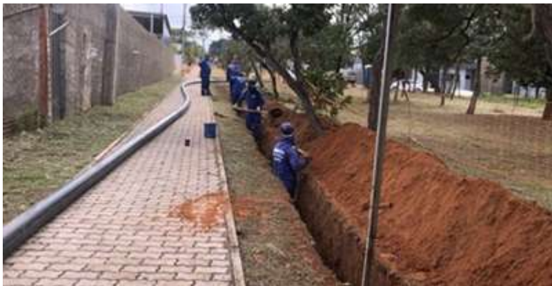
Implantação de redes de água no Setor Nova Colina
