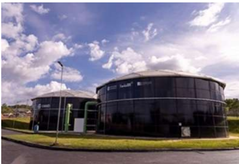
Reservatórios de água tratada do Sistema Paranoá Norte
