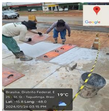
Execução de calçada estampada.
