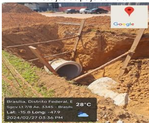
Execução de rede de drenagem.
