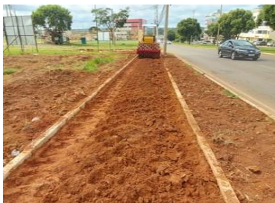
Compactação da camada de base.
