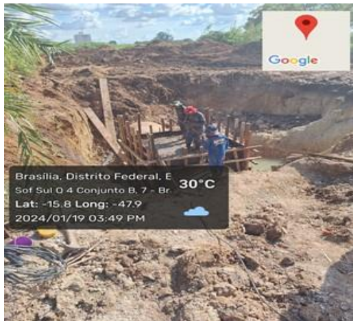
Execução de poço de visita.
