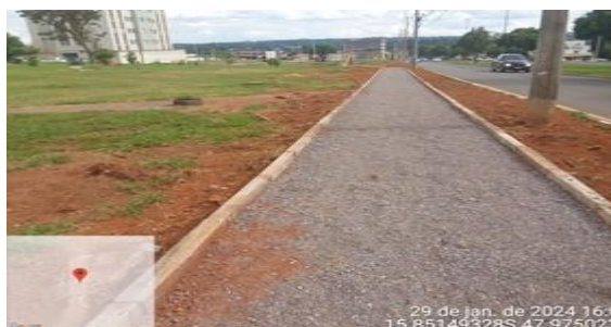
Execução de lastro de brita.
