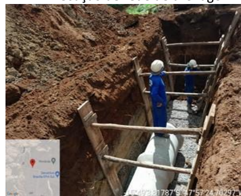
Execução de rede de drenagem
