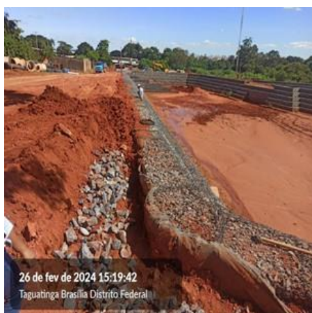
Execução da lagoa de retenção.
