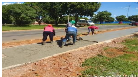
Execução de concretagem das calçadas.
