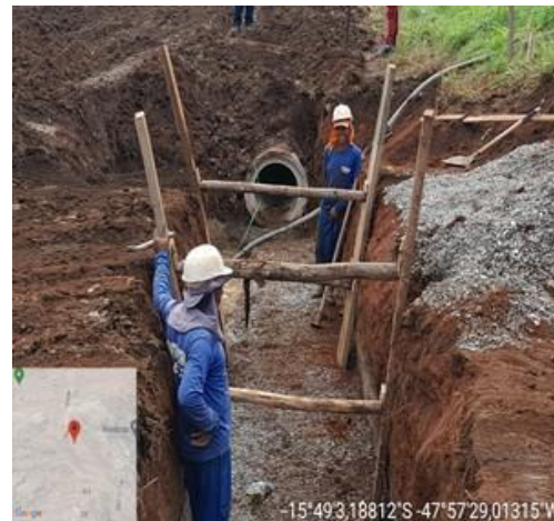
Execução de rede de drenagem.
