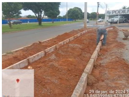
Instalação de cordão de concreto.
