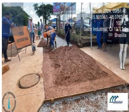
Execução de calçadas em concreto pigmentado.
