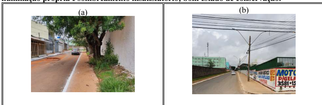
Figura 14 - Rotas Acessíveis Hospital Regional de Ceilândia - (a) e (b) - Inexistência de iluminação própria e sombreamento insatisfatório; bom estado de conservação.
