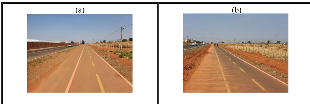
Figura 9 - VC-371 (BR-040/DF-290) - (a) Inexistência de iluminação própria e sombreamento; bom estado de conservação ; (b) plantio de mudas de árvores (lateral direita da figura).
