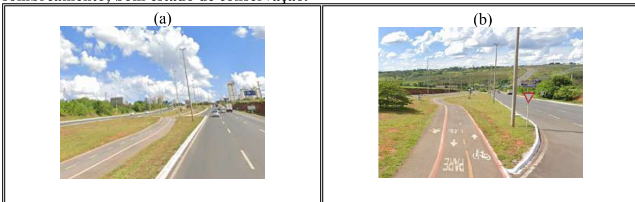
Figura 7 - DF459 - Ceilândia/Samambaia - (a) e (b) - Inexistência de iluminação própria e sombreamento; bom estado de conservação.
