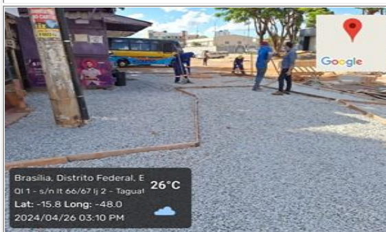
Preparação para execução de calçada.
