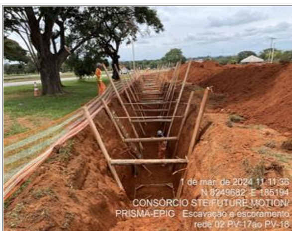
Execução de rede de drenagem pluvial - trecho 01.
