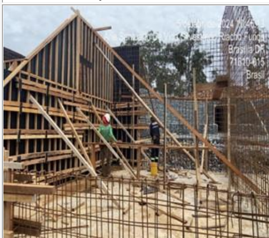
Execução da bacia de detenção
