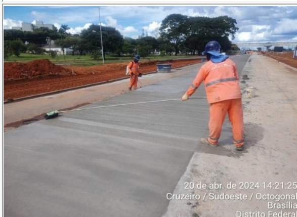
Execução de pavimento rígido (em concreto tipo whitetting) - trecho 01.
