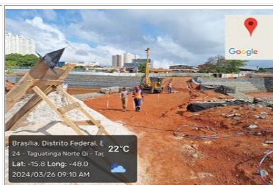
Execução de fundação da passarela.
