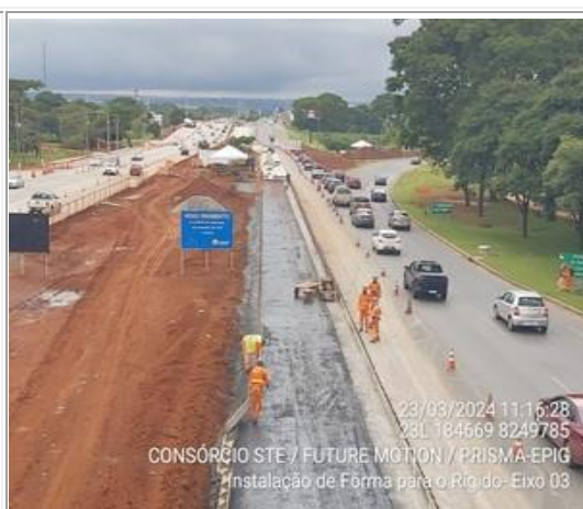
Execução de pavimento rígido (em concreto tipo whitetting) - trecho 01.
