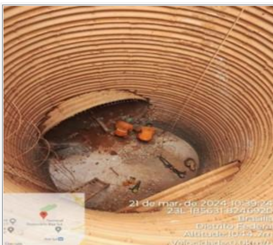
Execução de "tunnel liner"
