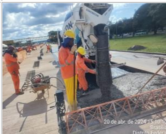
Execução de pavimento rígido (em concreto tipo whitetting) - trecho 01.
