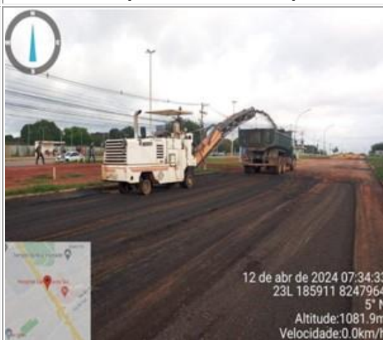
Execução de fresagem
