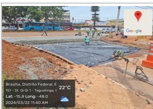
Execução de pavimento rígido (em concreto).
