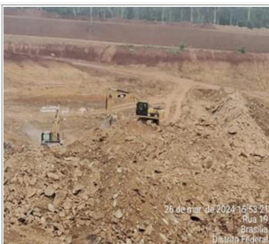
Escavação da bacia de detenção
