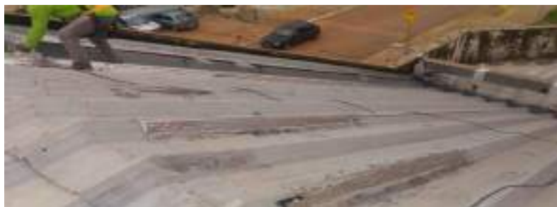
Figura 11 - Impermelização das telhas e dos rufos
