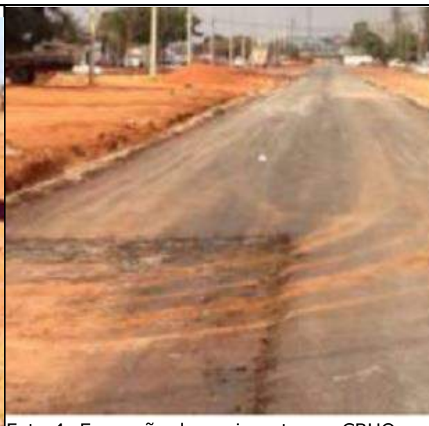
Foto 4: Execução de pavimento em CBUQ na via 3 e base na via 4 (ADE Centro Norte - Ceilândia)
