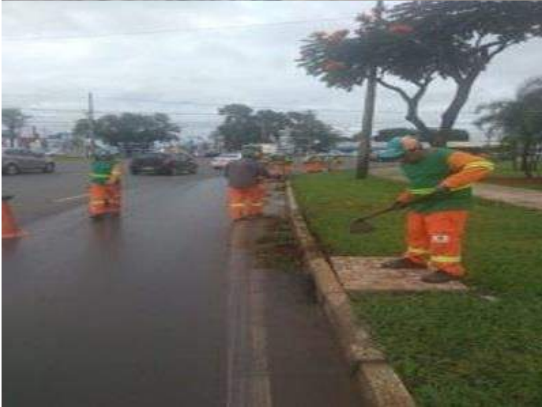
Serviços executados pela equipe da Administração Regional do SIA( diversos locais).
