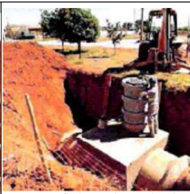
Foto 2: Execução de poço de visita da rede de drenagem 7
