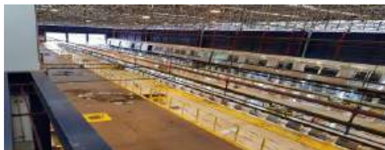
Figura 12 - Substituição de telhas
