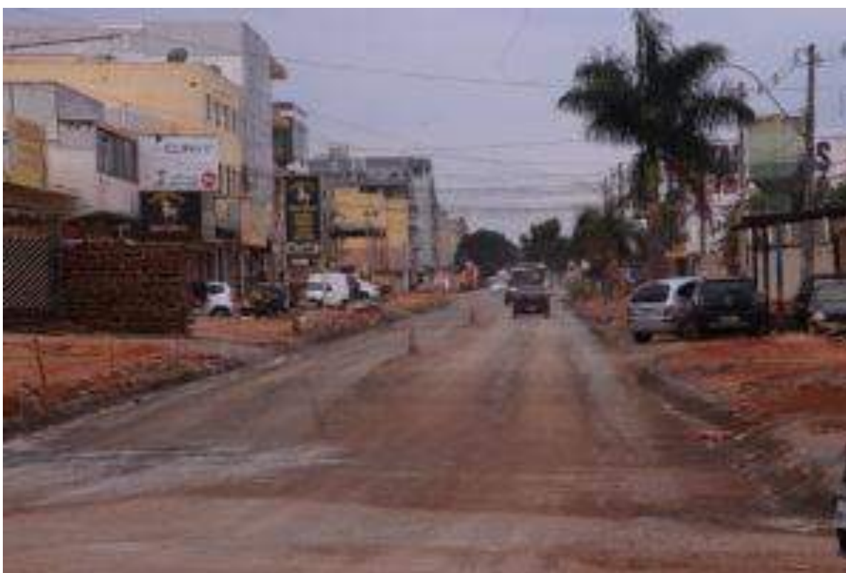
Rua 6 – Serviços de drenagem e pavimentação concluídos. Os meios-fios e as calçadas serão finalizados em 2020.
