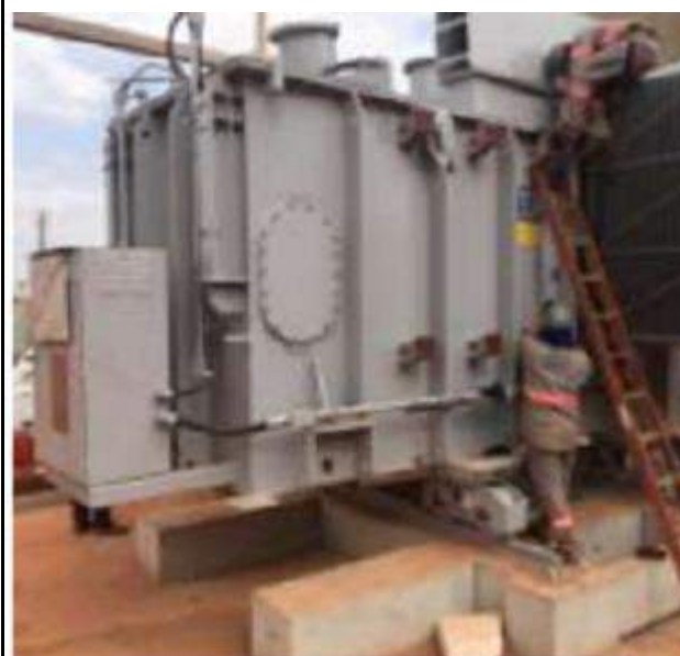
Foto 7: Colocação do Trafo e assentamento de acessórios, radiador
