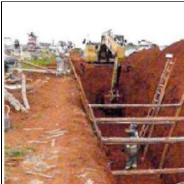
Foto 1: Execução de redes de drenagem pluvial
