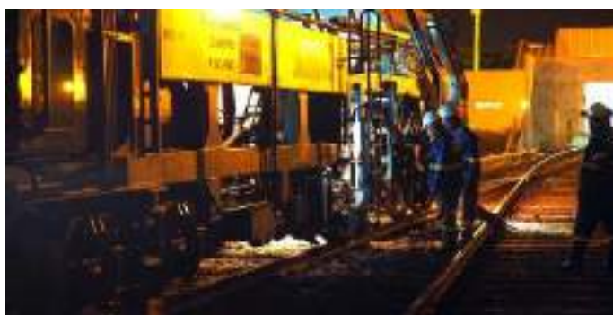
Figura 7 - Serviços de Alinhamento de Via
