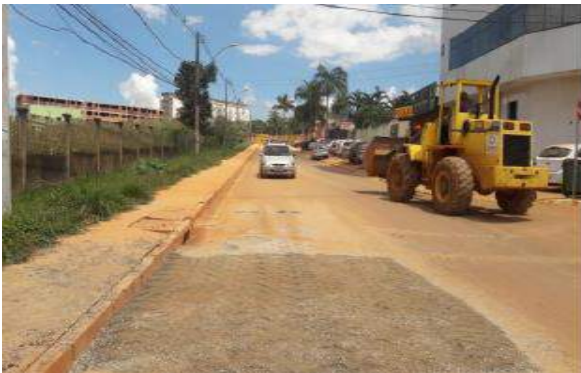
Rua 5 – Obras de pavimentação em andamento no trecho que vai do Balão do Horácio à Panificadora Bonanza. Parte dos serviços foi executada pelo DER. No restante da via, as obras de drenagem, pavimentação, meios-fios e calçadas serão finalizadas em 2020.
