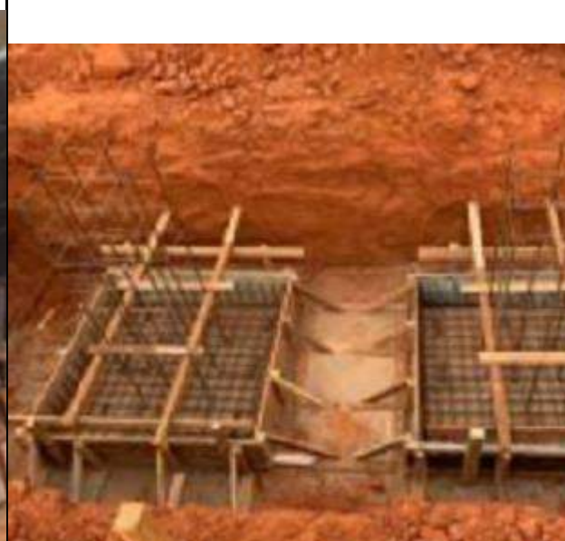
Foto 8: Fundação para estrutura básica
