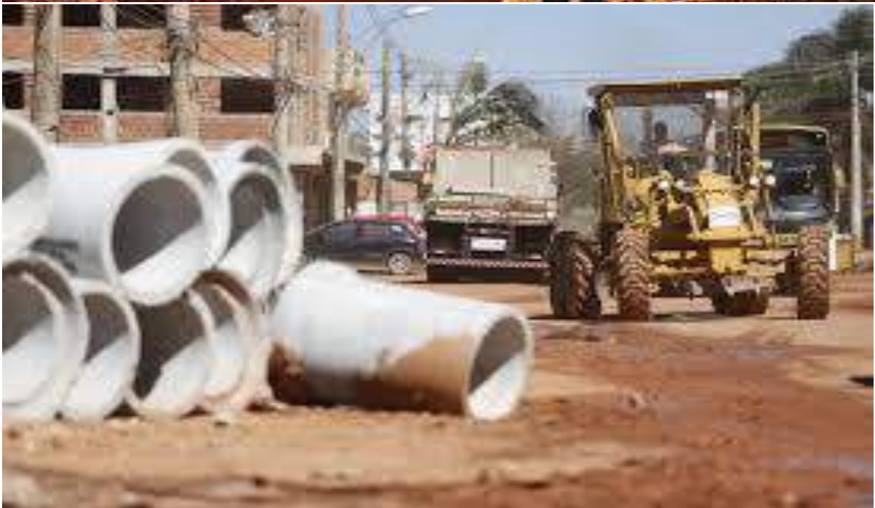
Rua 10 – Os 4,5 km da via com drenagem e asfalto foram concluídos. Também estão sendo instalados meios-fios, calçadas e aberturas de bocas de lobo. A previsão é de que a via seja
