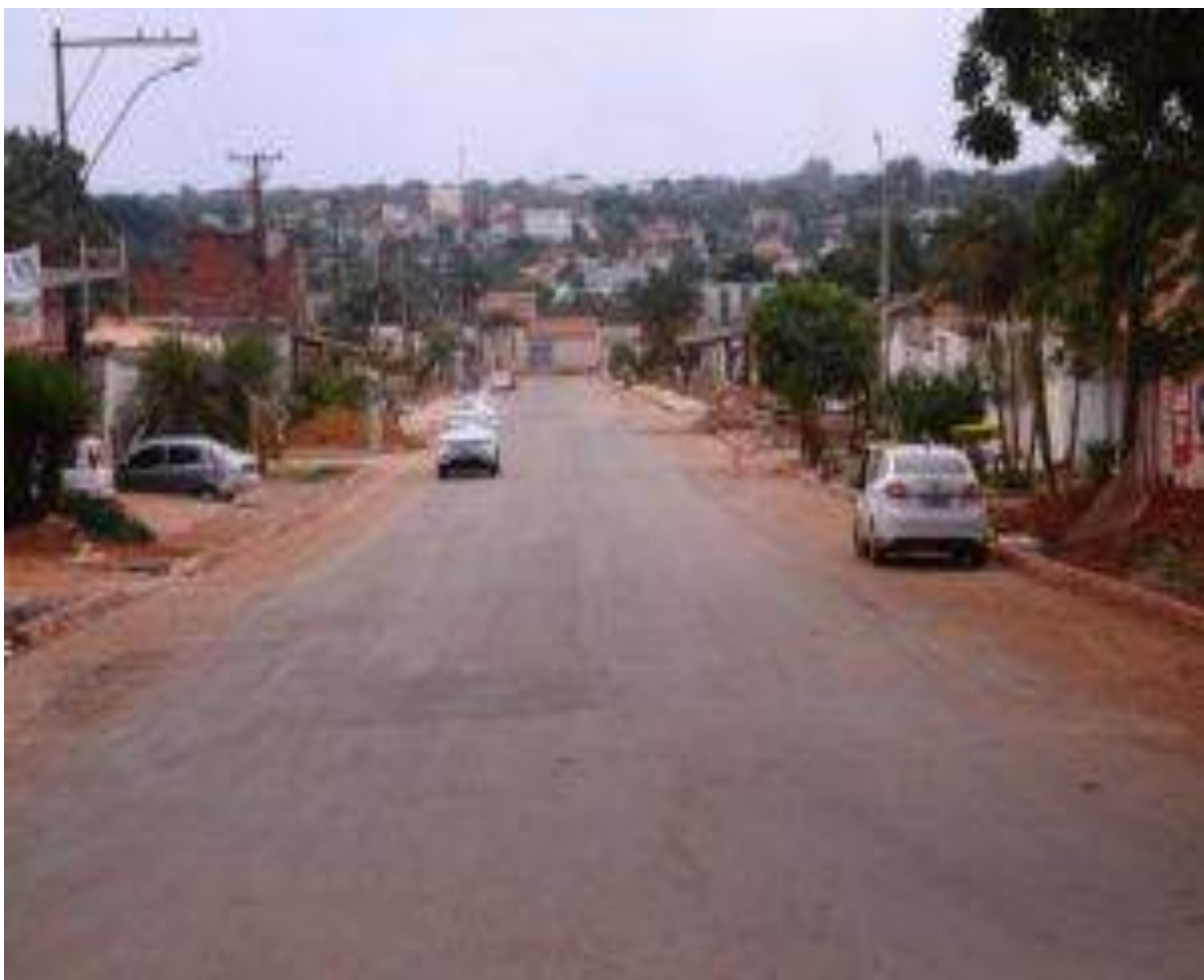
Rua 3C – Serviços de drenagem e pavimentação estão em fase final de conclusão. Os meios-fios e as calçadas serão finalizados em 2020.
