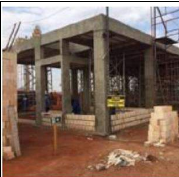
Foto 5: Alvenaria de fechamento do piso térreo da Sala de Comando
