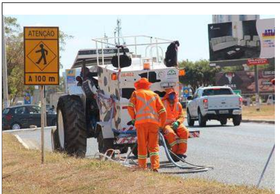
Foto 2: Pintura mecanizada de meios-fios
