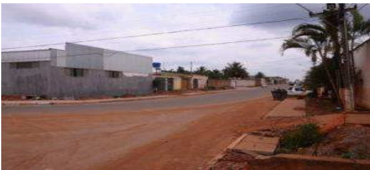
Rua 4 – Dos 3,1 km de extensão, 2,6 km estão concluídos com drenagem e asfalto. No momento, os serviços se concentram na terraplanagem e pavimentação entre as chácaras 300 e 297. Também estão sendo instalados meios-fios e calçadas na região. Os serviços de pavimentação asfáltica somente serão finalizados em 2020.
