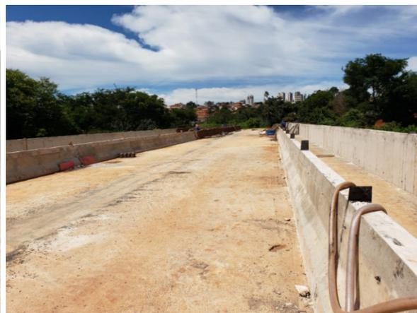
Concretagem do Tabuleiro da ponte (OAE)
