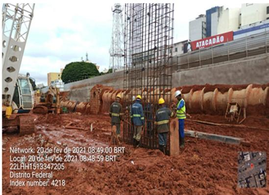
Preparo para concretagem das Lamelas da Parede Centro.
