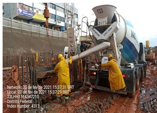
Concretagem das Lamelas da Parede do Centro.
