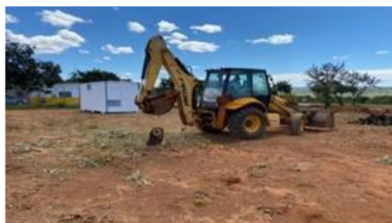
Destocamento de árvores
