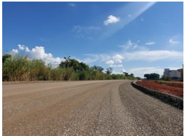
Execução de base
