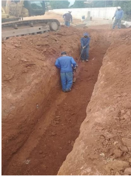
Escavação de vala e drenagem pluvial no trecho da Av. da Misericórdia.
