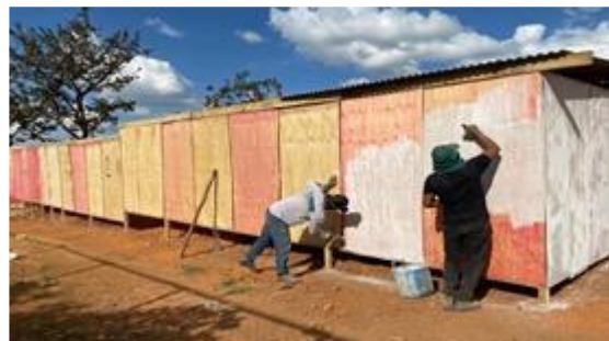
Instalação de canteiro de obras
