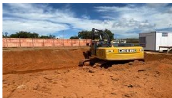
Serviço de terraplenagem
