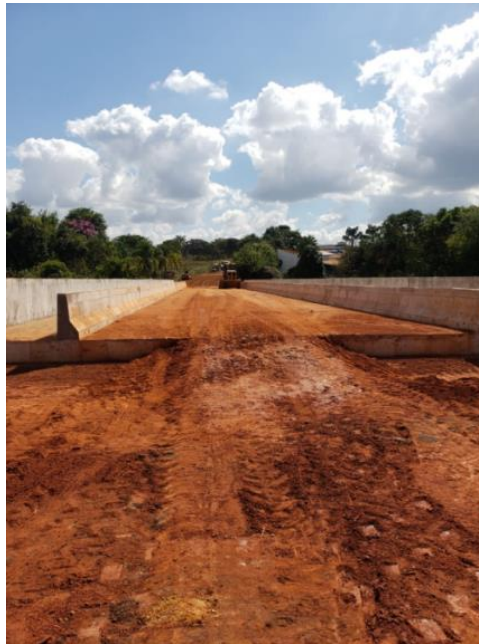
Execução de sub-base no trecho da Av. da Misericórdia
