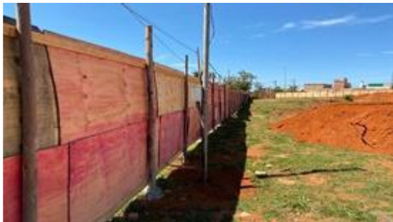
Instalação de poste de medição CEB
