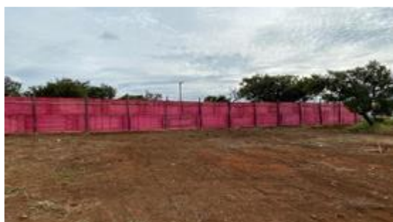
Instalação de tapume
