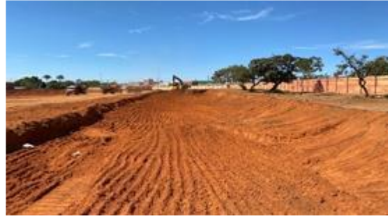
Serviço de terraplenagem
