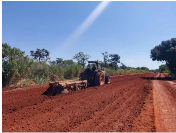
Execução de sub-base
