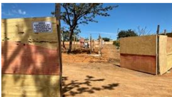
Instalação de canteiro de obras
