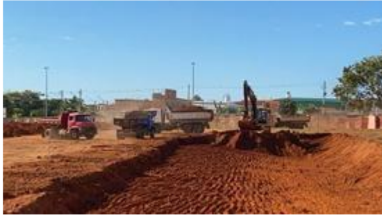
Serviço de terraplenagem
