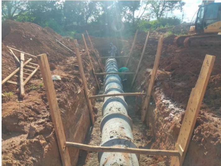
Execução de drenagem pluvial
