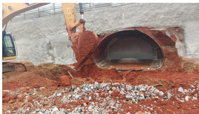
Estabilização com concreto projetado
