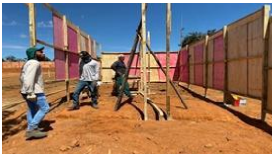
Instalação de canteiro de obras
