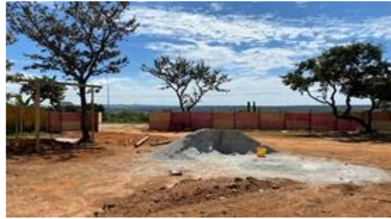
Instalação de canteiro de obras
