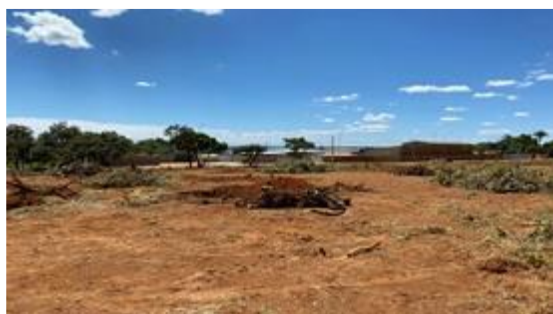
Destocamento de árvores
