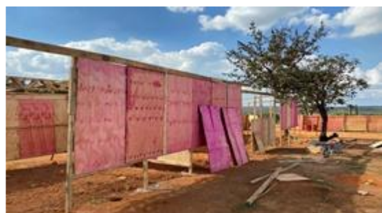
Instalação de canteiro de obras
