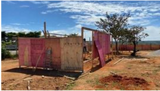
Instalação de canteiro de obras
