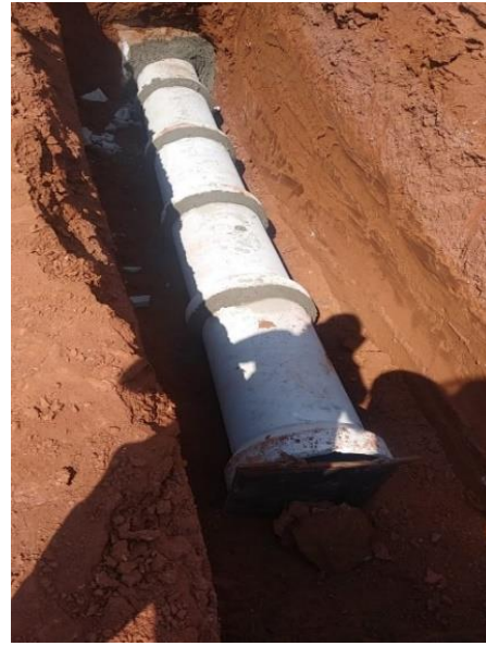
Escavação de vala e drenagem pluvial no trecho da Av. da Misericórdia.
