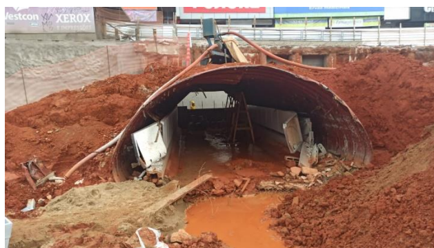
Demolição parcial da passarela do Metrô.
