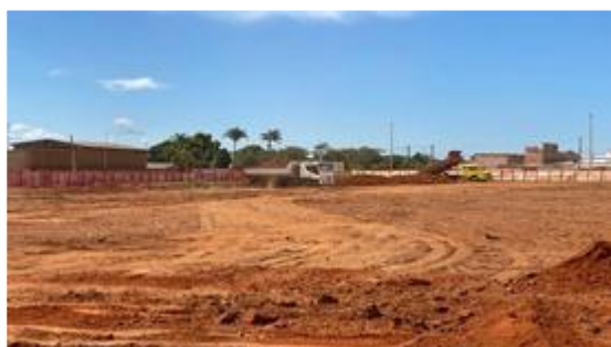
Serviço de terraplenagem
