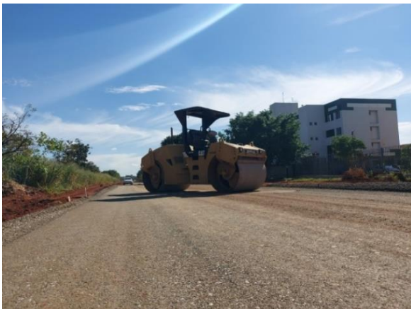
Execução de base
