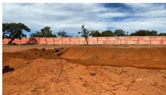
Serviço de terraplenagem
