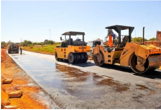
Execução de imprimação sobre base de BGS
