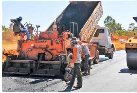
Execução de pavimentação asfáltica
