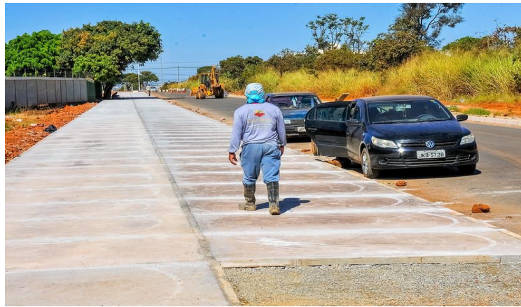
Execução de calçada/ciclovía em concreto
