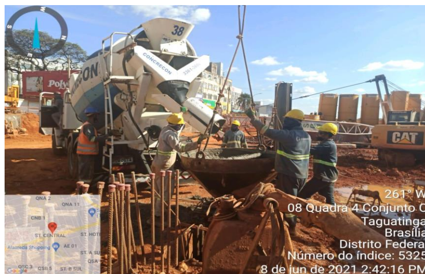
Concretagem de Parede Diafragma
