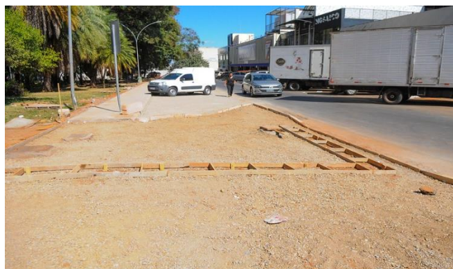
Preparo do solo para concretagem de calçada
