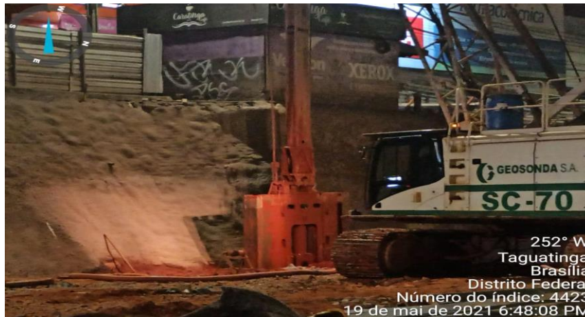
Escavação para execução de Parede Diafragma (Trabalho Noturno)
