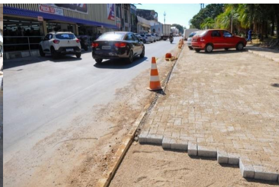
Assentamento de blocos intertravados e meios-fios de concreto
