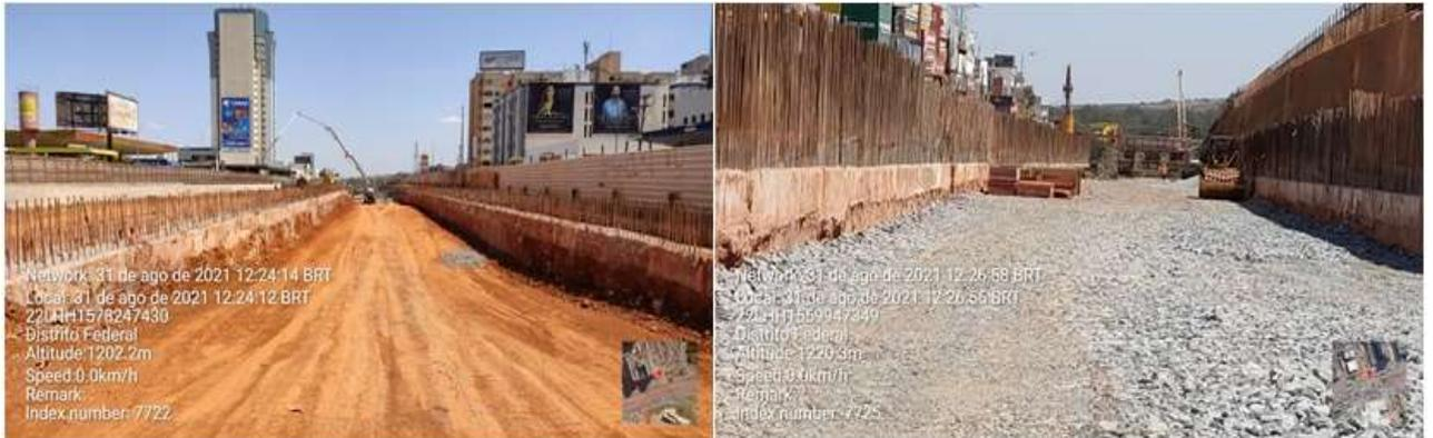
Lançamento de brita nº 4 (Camada de suporte para execução de laje de cobertura)
