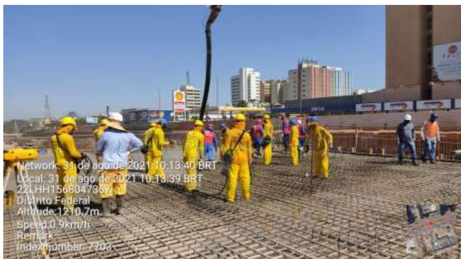
Armação e concretagem da laje de cobertura
