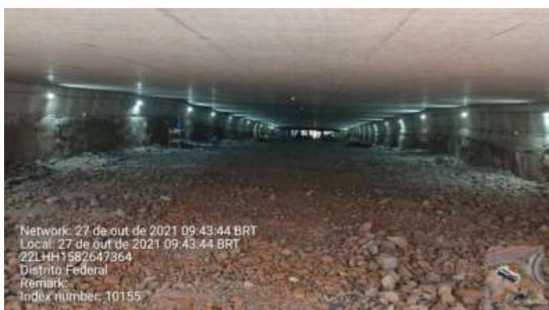
Desforma da laje de cobertura (Módulos 11 e 9).
