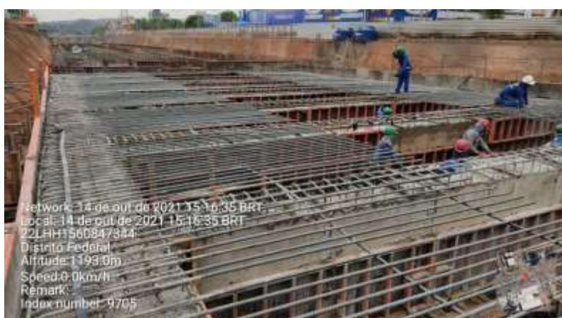
Concretagem das Vigas de coroamento (V1 e V2; V3 a V10), até fundo da laje *nervurada*.
