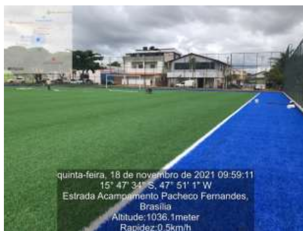
Instalação de grama sintética em fase de conclusão
