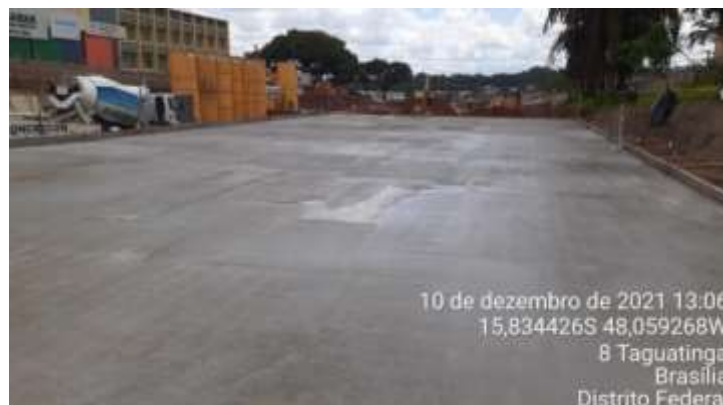
Concretagem da Desforma da laje do Módulo 14.
