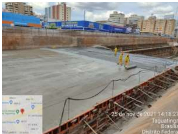
Concretagem da laje do Módulo 2C.
