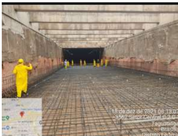
Armação da laje de fundo - (Módulo Pergolado).
