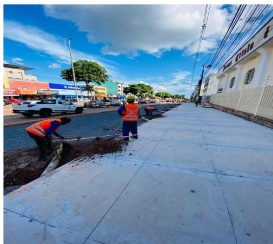
Av. Paranoá - Trecho 2 - lado A - Execução de estacionamento e concretagem das calçadas
