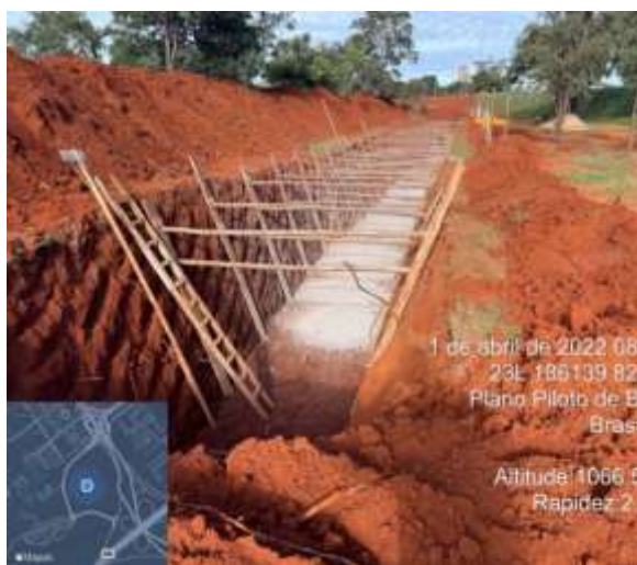
Escoramento/preparo de fundo de vala
