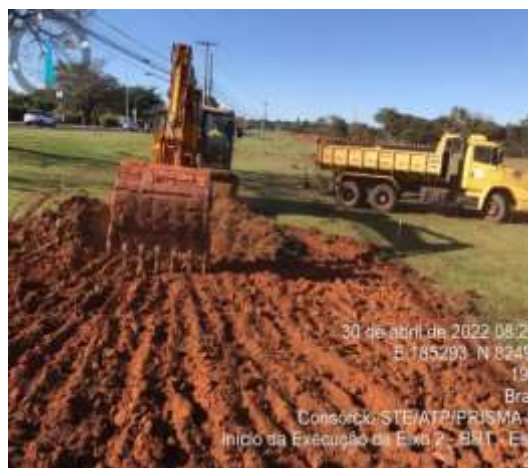
Terraplenagem - Eixo 2 - BRT
