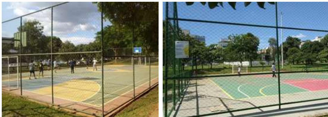
Intervenção em quadra poliesportiva da 110 Norte
