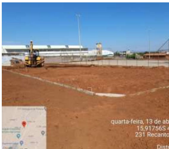
Terraplenagem/Demarcção de calçada
