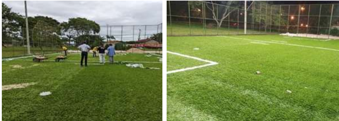
Intervenção em campo sintético da Vargem Bonita
