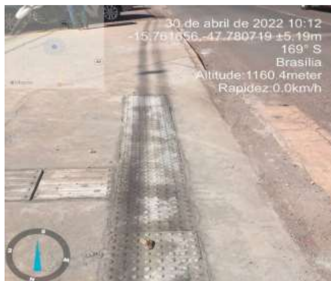
Instalação de piso tátil
