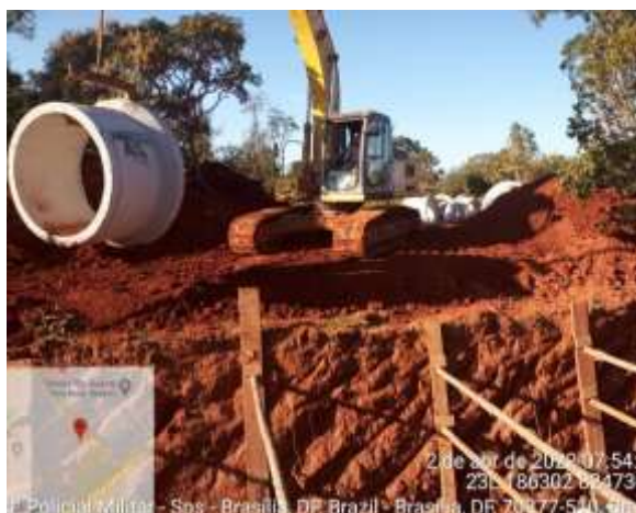
Transporte de tubos de concreto
