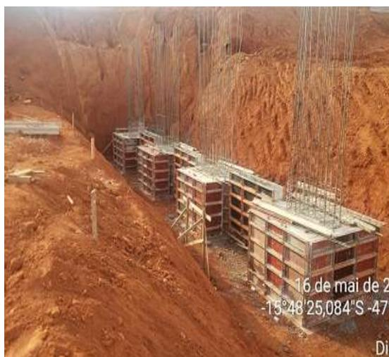
Execução de armação forma de blocos e pilares (EPIG)
