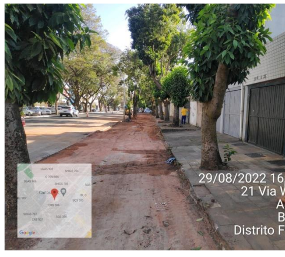
Demolição de calçadas antigas
