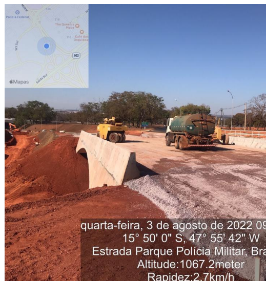
Compactação da base em BGS (brita graduada simples) no viaduto 63 - ESPM
