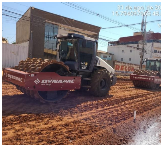
Execução e compactação da sub-base - SHVP
