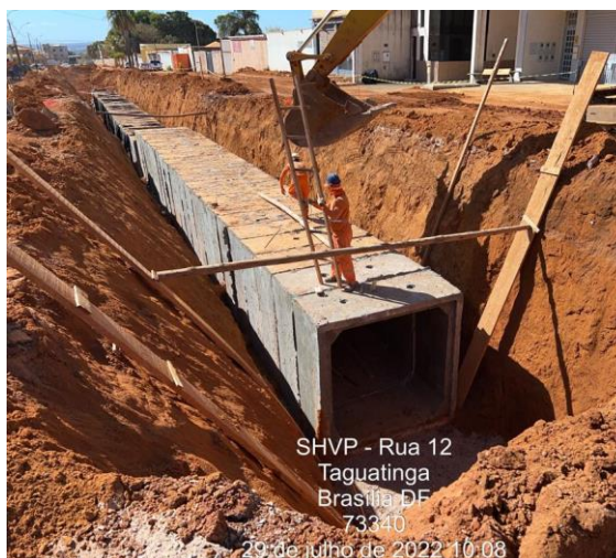
Execução de rede de drenagem pluvial - SHVP
