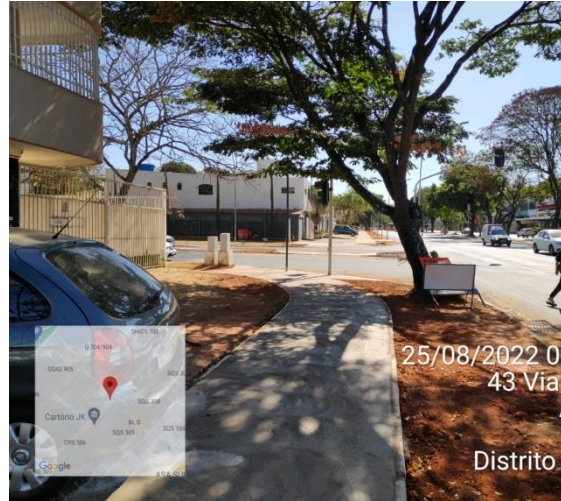
Execução de calçadas e rampas
