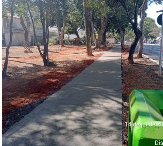
Execução de calçadas
