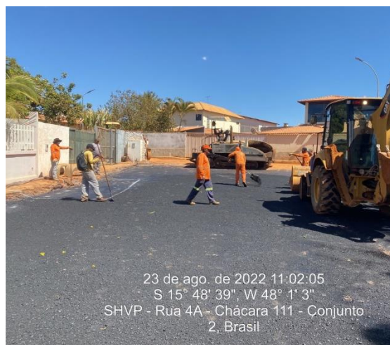
Execução pavimentação asfáltica - SHVP
