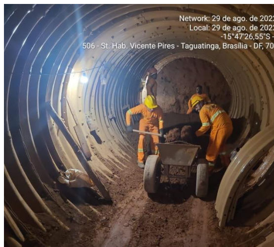
Execução de "Tunnel Liner" - SHVP
