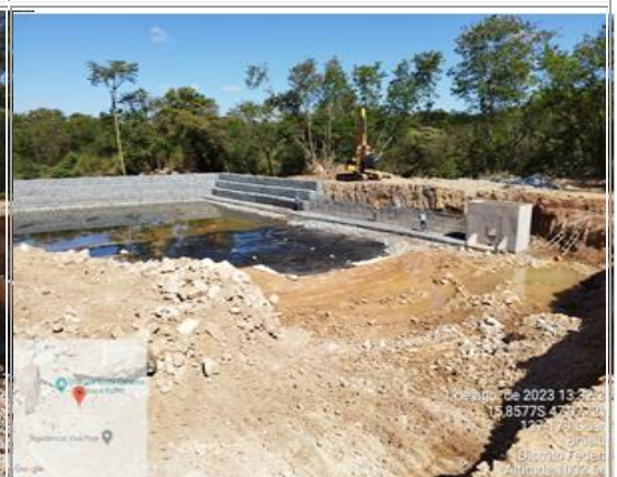
Execução do colchão reno e muro de gabião da Bacia 11.
