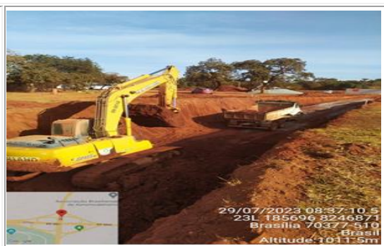
Execução da galeria de concreto 03x03.
