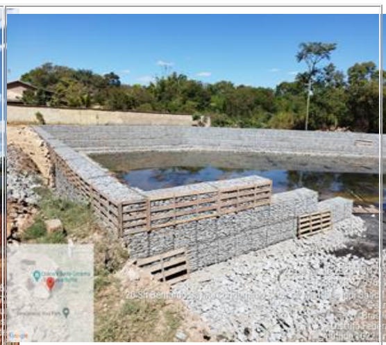
Execução de gabião da Bacia 11.
