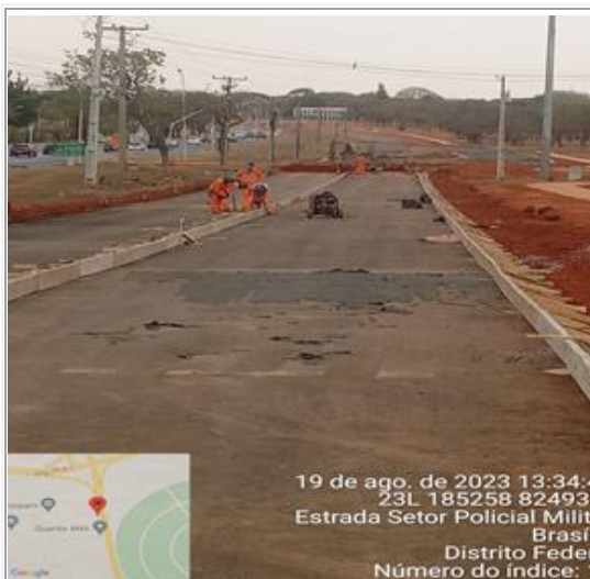
Montagem de fôrmas - pavimento rígido.
