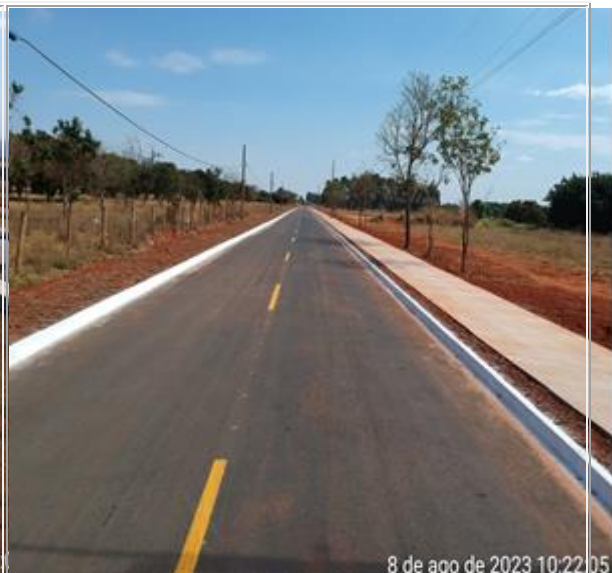
Via de ligação CAUB I e II - Pavimentação, sinalização horizontal, meios-fios e calçadas concluídas.
