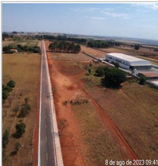
Via de ligação CAUB I e II - Vista aérea - Obra concluída
