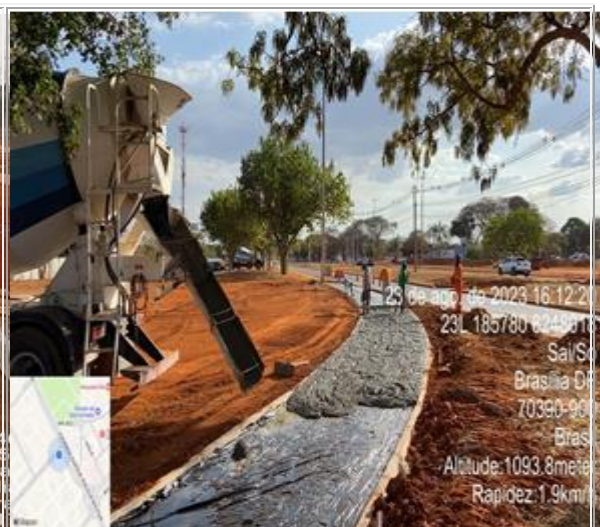
Execução de ciclovias.
