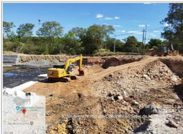
Execução de escavação da Bacia 11.
