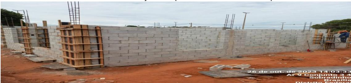
Obra CMB Sobradinho II em execução de paredes e pilares. 20% concluída
