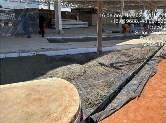
Concretagem do pavimento rígido (baias)
