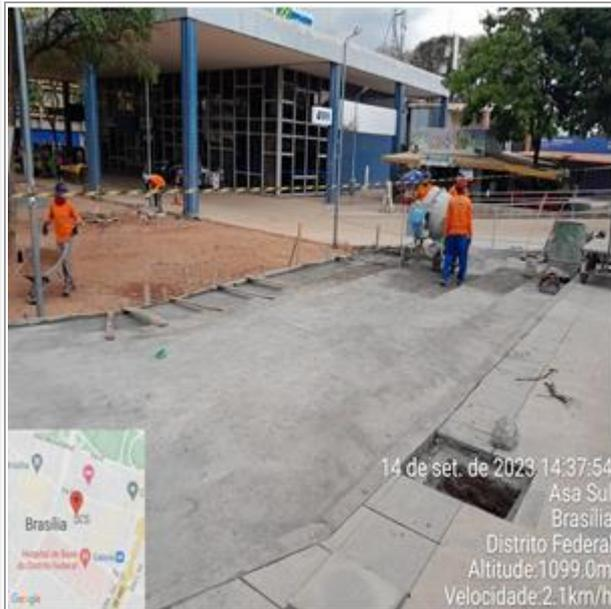
Execução de escada em concreto/assentamento de cordão de concreto.
