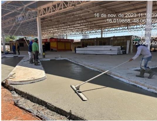
Concretagem do pavimento rígido (baias)
