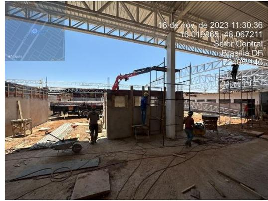
Execução de Estrutura Metálica da cobertura
