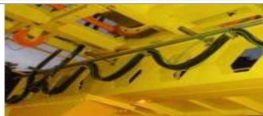
Substituídos cabos, painéis e toda instalação elétrica Instalação do novo Festoon
