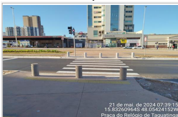
Instalação de balizador
