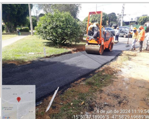
Execu43o de ciclovia
