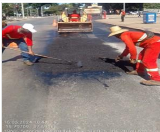
Execução de faixa de transição em asfalto (CBUQ).
