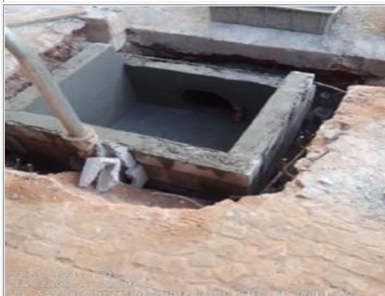
Execução de boca de lobo.
