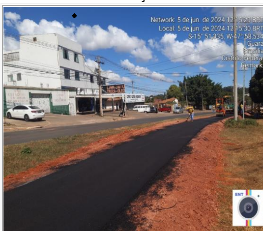
Execu43o de ciclovia
