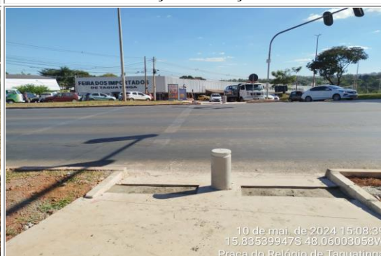
Instalação de balizador.
