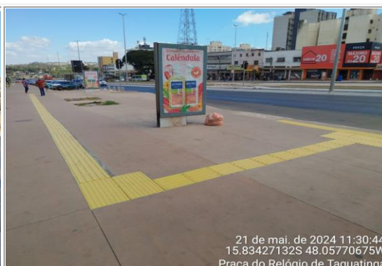
Execução de calçadas.
