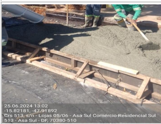
Concretagem do pavimento rígido (concreto).
