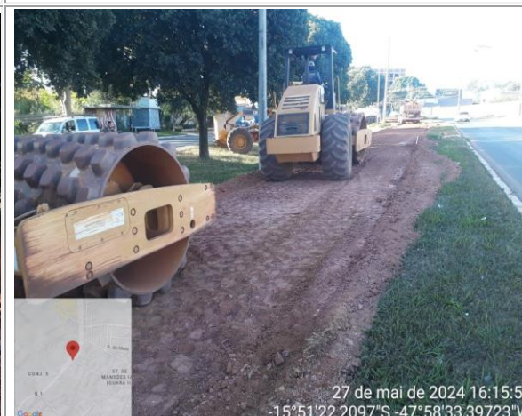
Execu43o de ciclovia.
