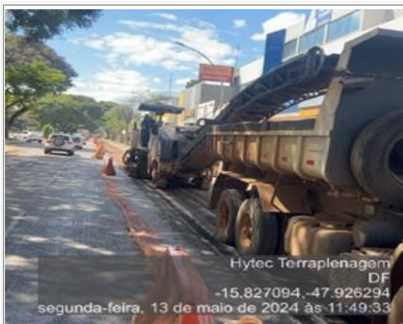
Execução de fresagem.
