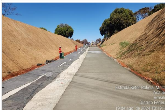
Pavimento rígido (concreto)/proteção de taludes
