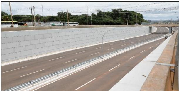
Antes da construção do complexo viário, o tráfego era guiado por uma rotatória em nível, que já não comportava mais a demanda de veículos, gerando constantes congestionamentos. Para solucionar esse problema, foi construída uma estrutura em trincheira, com profundidade de cerca de sete metros e extensão de aproximadamente um quilômetro e meio, além de duas alças de retorno.
