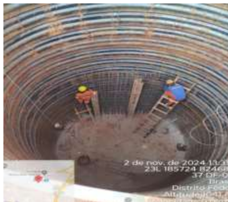
Execução de tunnel liner.
