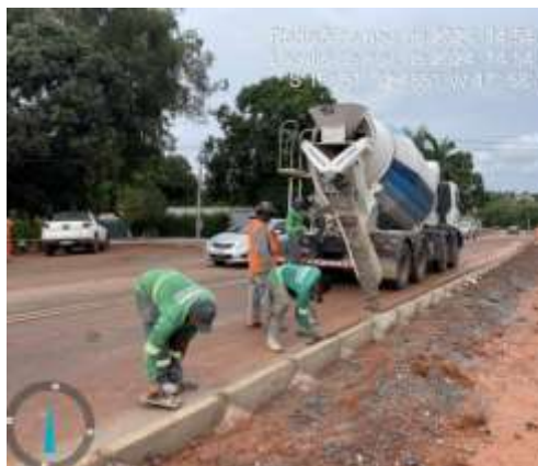
Concretagem da sarjeta.
