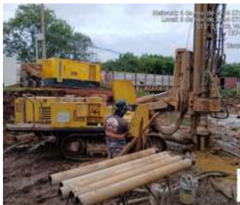
Execução de fundação OAE.
