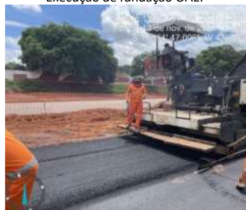
Execução de pavimento asfáltico.
