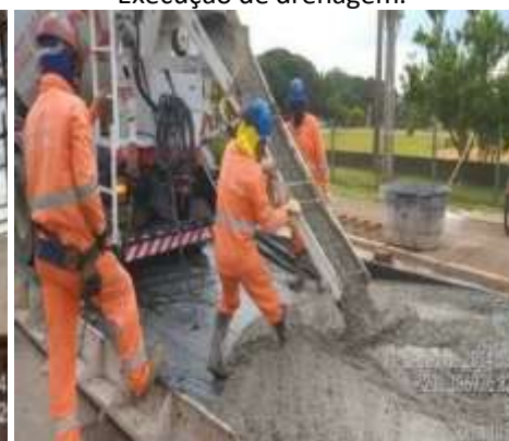
Execução de pavimento rígido.
