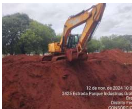
Execução de terraplenagem.
