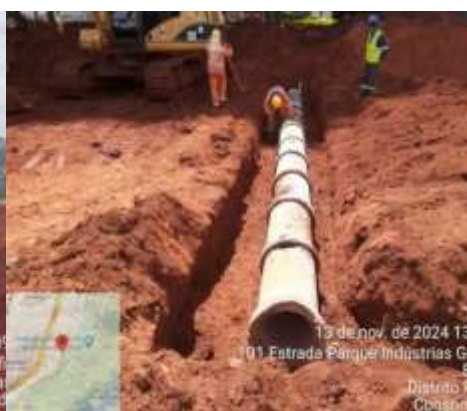
Execução de drenagem.
