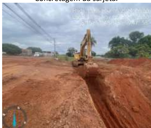
Escavação da bacia.
