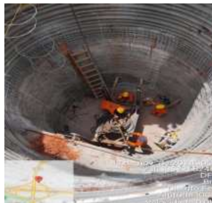
Tracionamento de escudo metálico.
