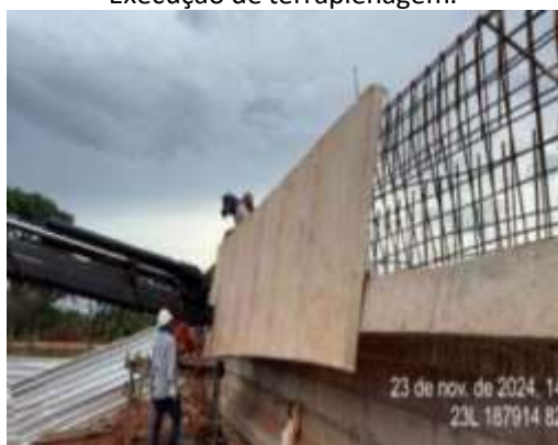
Instalação de placas pré-moldadas laterais – OAE.
