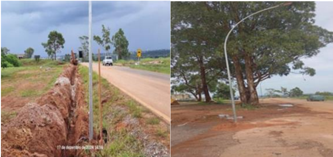
Implantação de rede de Iluminação Pública no Núcleo Rural Monjolo
