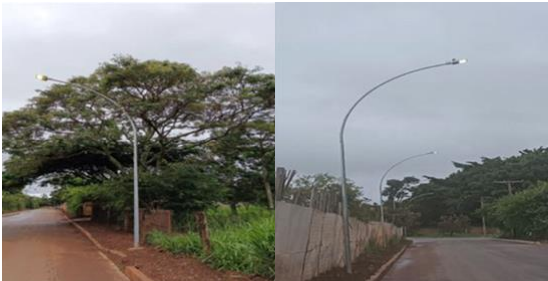
Implantação de Iluminação Pública na Rua Primavera - Ponte Alta
