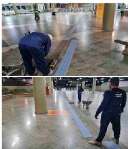
Instalação de pisos táteis
