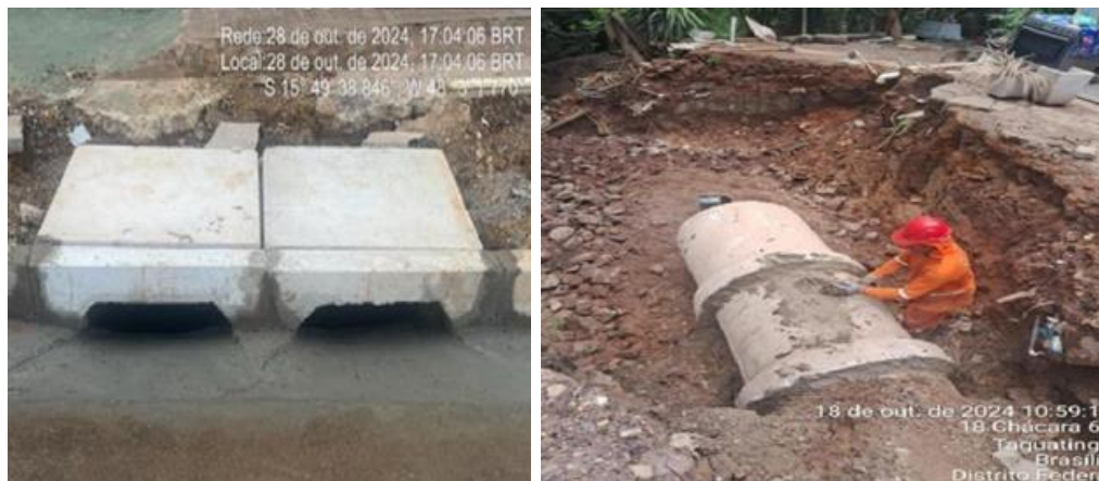
Contrato nº 29/2023 - Infraestrutura no Vicente Pires
