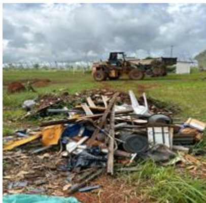
Figura: Retirada de entulhos UIPSS
