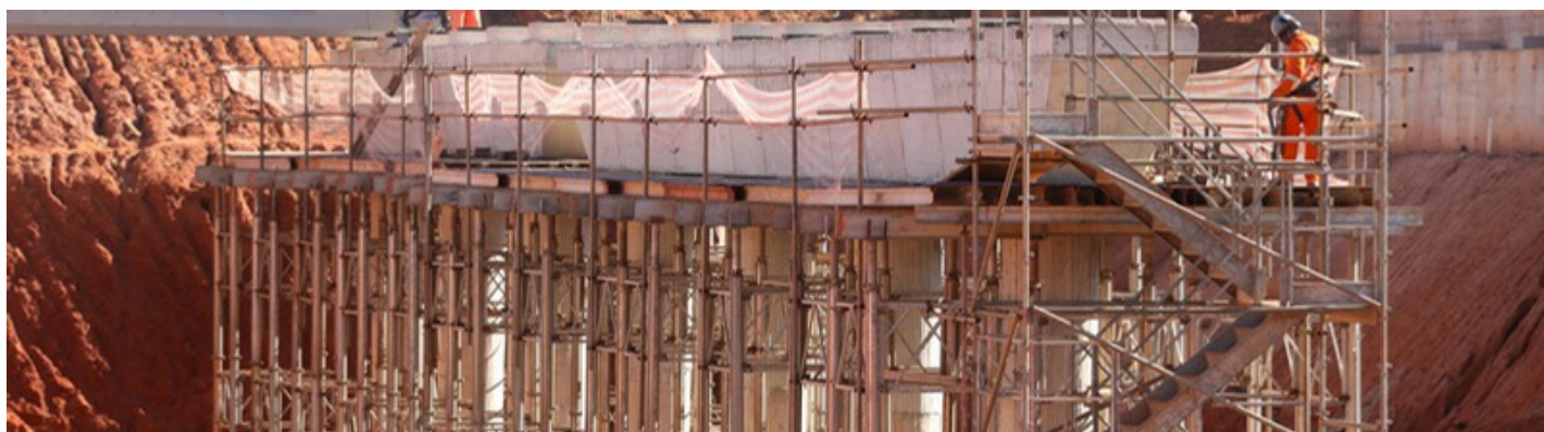
Governo inicia içamento de vigas que darão sustentação ao viaduto da Epig. Agência Brasília.
