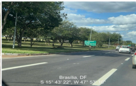
DF- 009 - Sinalização/Tacha refletiva.
