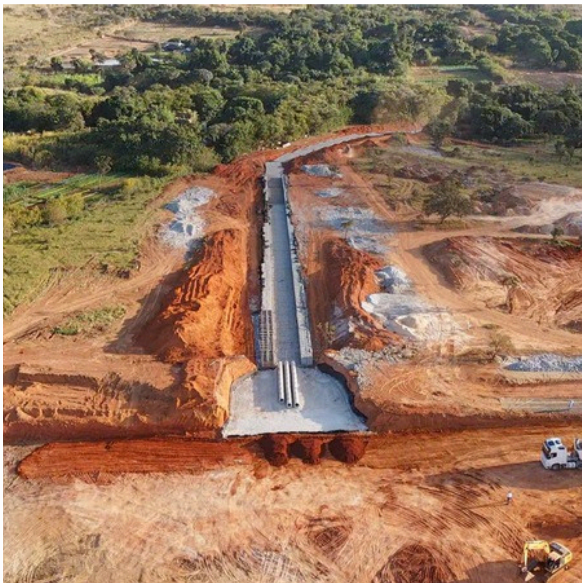
Começam as obras da expansão da Linha 1 do Metrô-DF em Samambaia. Agência Brasília.
