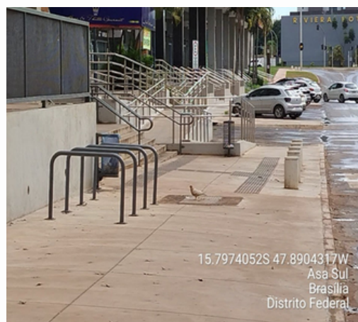
Calçada, piso tátil direcional, meios-fios e instalação de balizadores.
