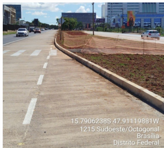
Trecho 6 - Calçada, meios-fios e grama.
