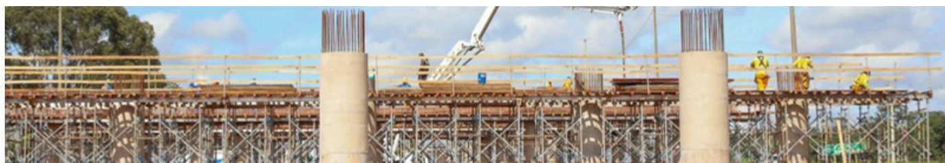
Equipes do GDF trabalham na implantação de vigas do Viaduto de Planaltina e na terceira faixa da BR-020. Agência Brasília (09/03/2026).
