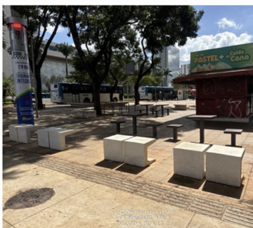
Calçada/piso tátil direcional.
