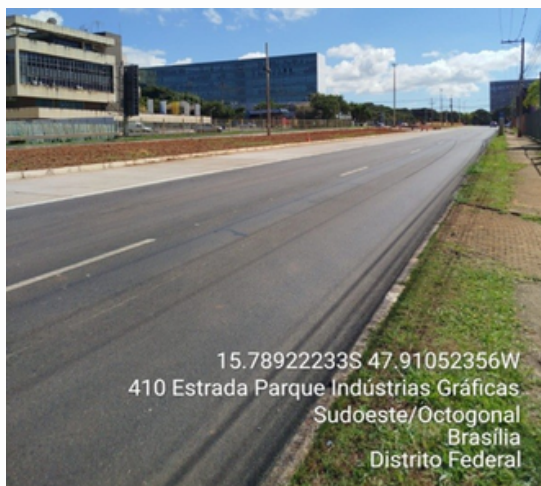
Trecho 6 - Pavimento asfáltico (flexível) e calçadas.
