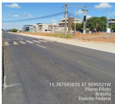
Trecho 4 - Pavimento asfáltico (flexível).
