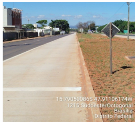
Trecho 4 - Pavimento asfáltico (flexível)
