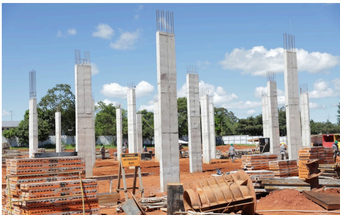
Obras do Hospital do Recanto das Emas chegam à segunda etapa com 96% da fundação concluída. Agência Brasília (02/04/2026).
