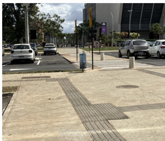
Calçada/piso tátil direcional.
