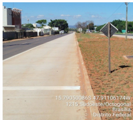
Trecho 4 - Pavimento asfáltico (flexível)
