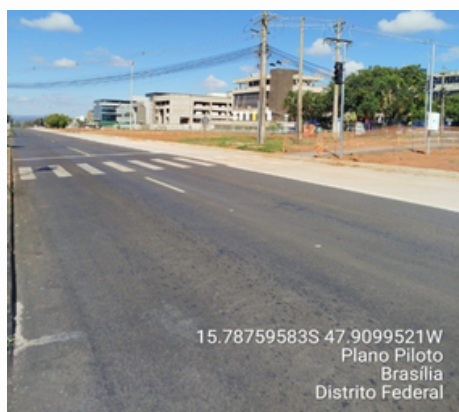
Trecho 4 - Pavimento asfáltico (flexível).
