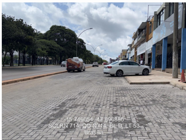
Pavimentação em blocos intertravados, assentamento de meios-fios e execução de calçadas
