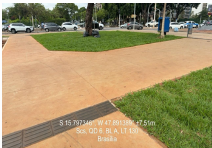
Execução de calçadas e assentamento de piso tátil
