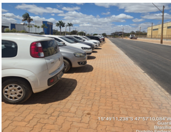
Pavimentação asfáltica e em blocos intertravados
