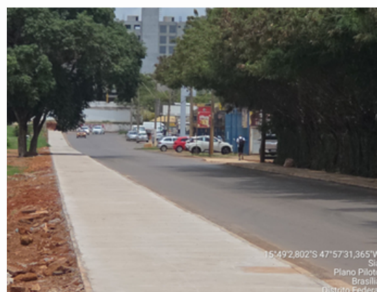
Execução de calçadas, pavimentação asfáltica e assentamento de meios-fios
