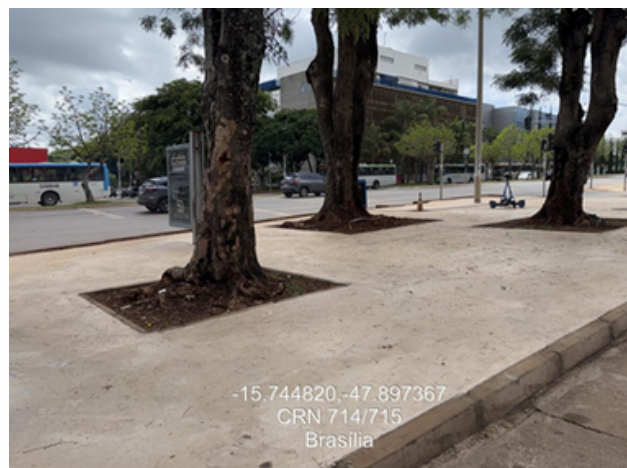
Execução de calçadas e assentamento de meios-fios
